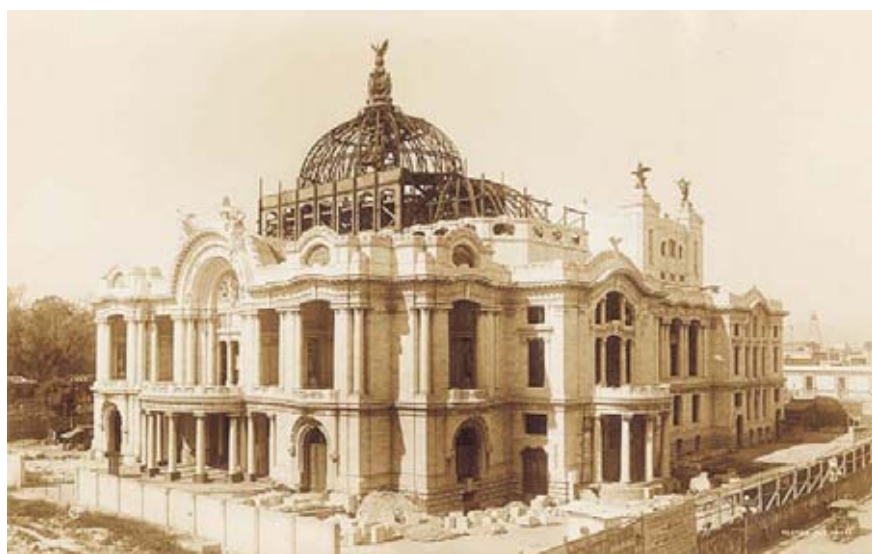
Aspecto de la construcción del Palacio de Bellas Artes en 1909.
