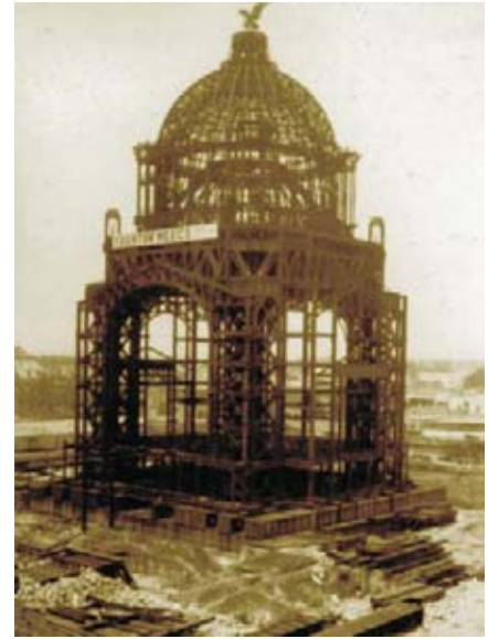
Estructura metálica del Monumento a la Revolución.
