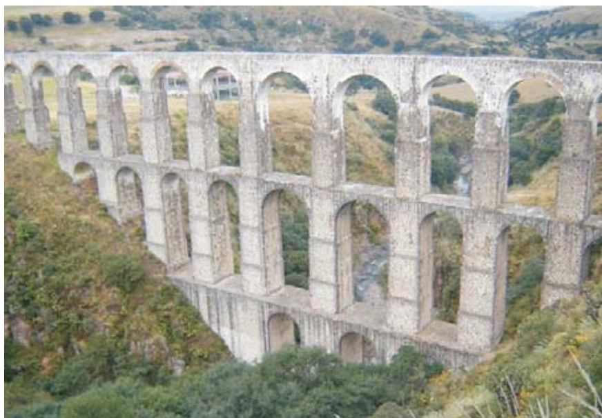
Acueducto de Xalpa, también conocido como «Arcos del Sitio», construido entre los siglos XVIII y XIX en Tepotzotlán, Estado de México.
