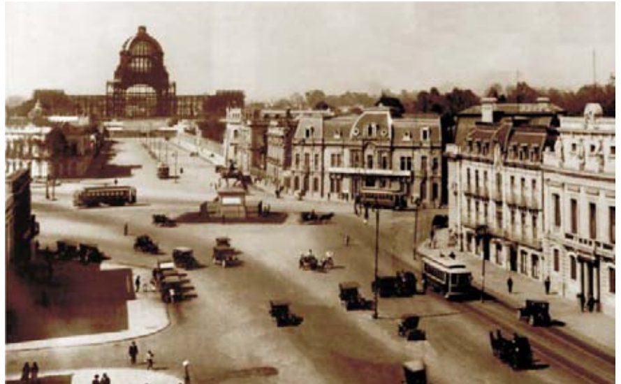
Aspecto de la estructura metálica de lo que en un principio sería el Palacio Legislativo Federal. El proyecto original fue interrumpido en 1910. La estructura fue aprovechada para construir un monumento conmemorativo de la Revolución Mexicana.
