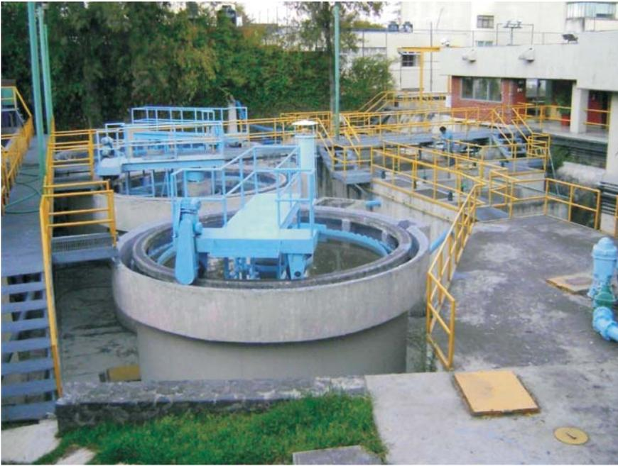
**Figura 4.** Vista de las instalaciones de la planta potabilizadora de aguas residuales de Cerro del Agua. Recibe aguas residuales y pluviales del Colector Zona Antigua o Casco Viejo, del Colector Circuito Exterior y del Colector de la colonia Copilco el Alto.
